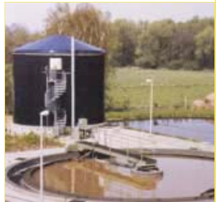
Oben: Anaerobanlage Unten: Tropfkörper
