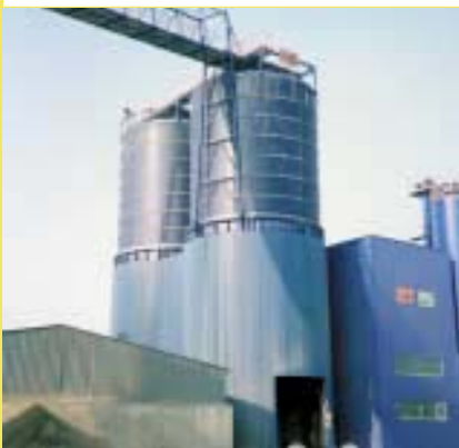
Oben: Kohlenaschelager Unten: Gemahlene Hochofenschlacke
