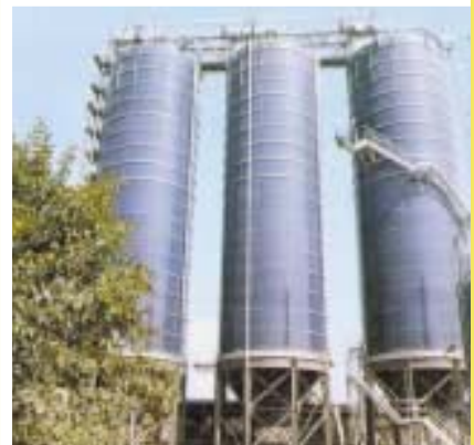
Oben: Fleischmehlbunker Unten: Maisstärkelager
