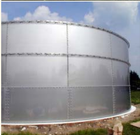
oben: Trinkwasserbehälter 2 x 1.000 m 3 unten: Schlammbehälter 700 m 3
