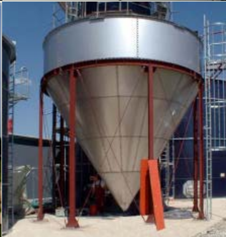
oben: Detail Aussteifungswinkel unten: Trichterbehälter 100 m 3 in einer Kläranlage
