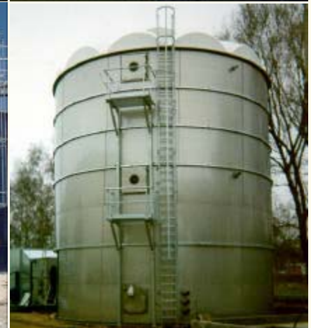
oben: Fäkalschlammbehälter 325 m 3 unten: Behälter als Abluftfilter 680 m 3
